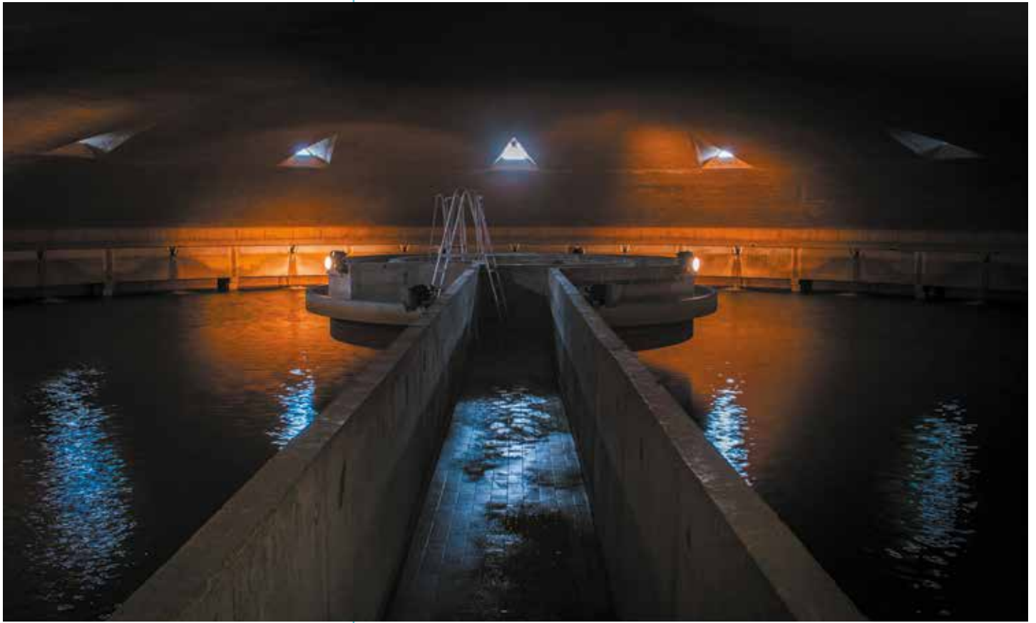
L'intérieur du réservoir de Loverval © Grégory Demars (Recherche Fuites Couillet)
